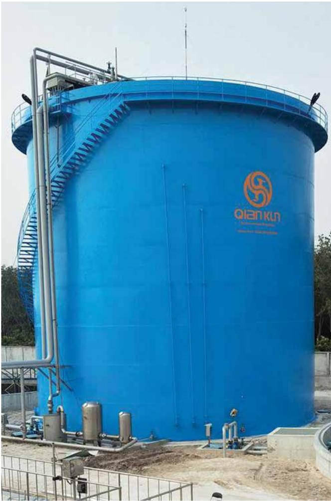
presenta un estudio en el que se observó una variación en el patrón de flujo como consecuencia de la variación de la velocidad ascensional de operación de un reactor anaerobio de flujo ascendente con lecho de lodos. El reactor operó a tres velocidades ascensionales: 0.5, 1.0 y 1.5 m/s, y al final se obtuvo un patrón de flujo con menor volumen en zonas estancadas con una velocidad de 1.5 m/h.
